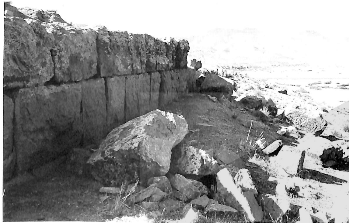
FIG. 7. – Vue du mur d'enceinte au nord-ouest. Assises en grand appareil (cliché J.L. Soulé).
